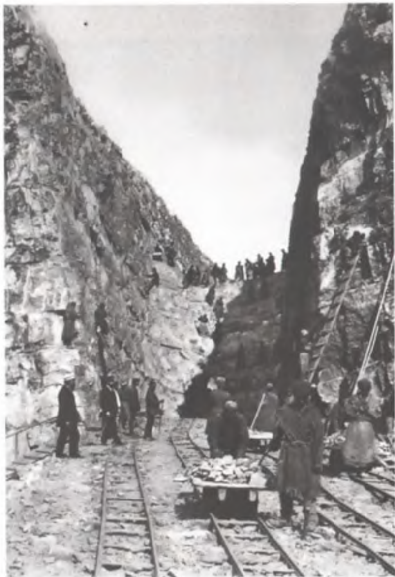
Строители Ташкентской ж. д. 1902 г.
