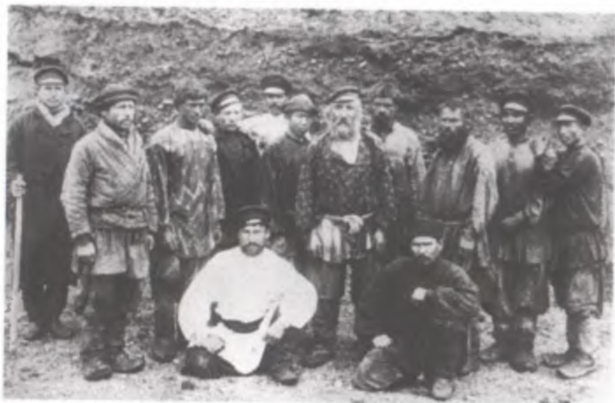
Строители Ташкентской ж. д. 1903 г.
