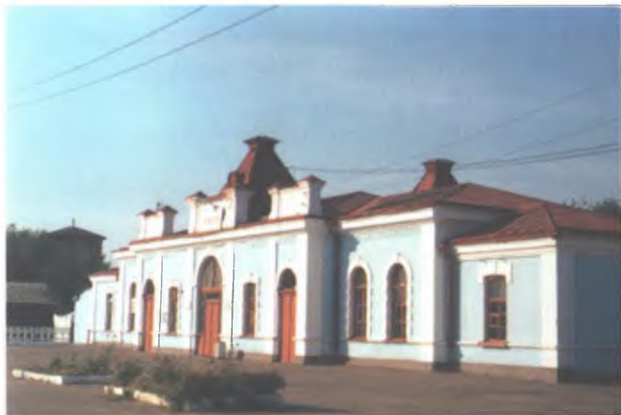
Пассажирское здание на ст. Ак-булак. 2005 г.
