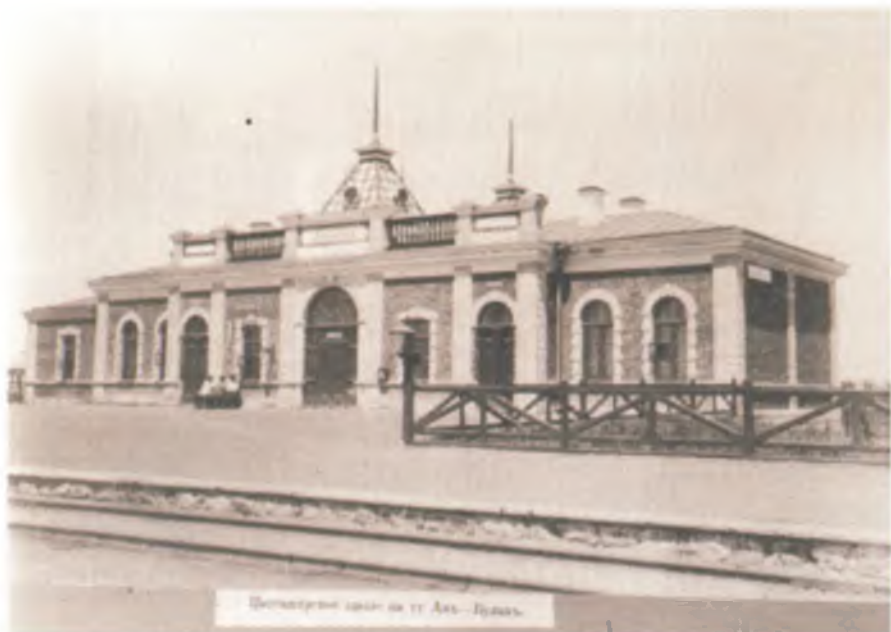
Пассажирское здание на ст. Ак-булак. 1905 г.
