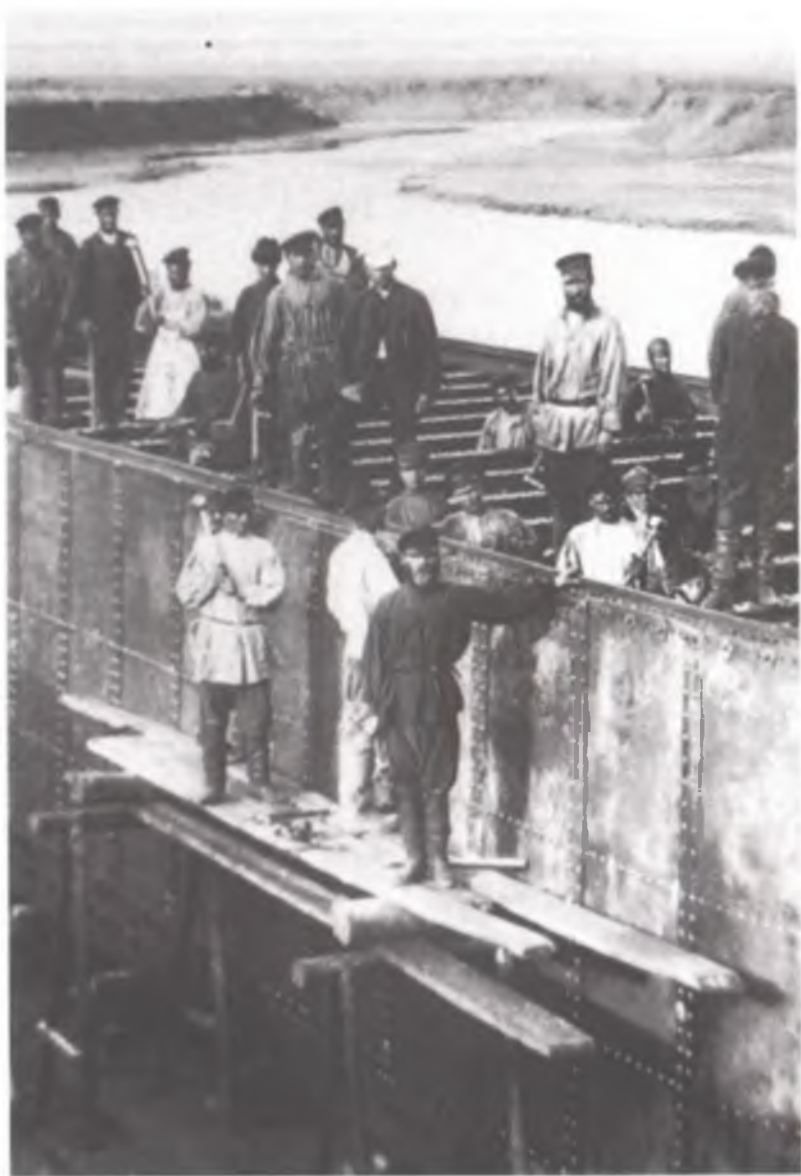
Строители Ташкентской ж. д. 1903 г.
