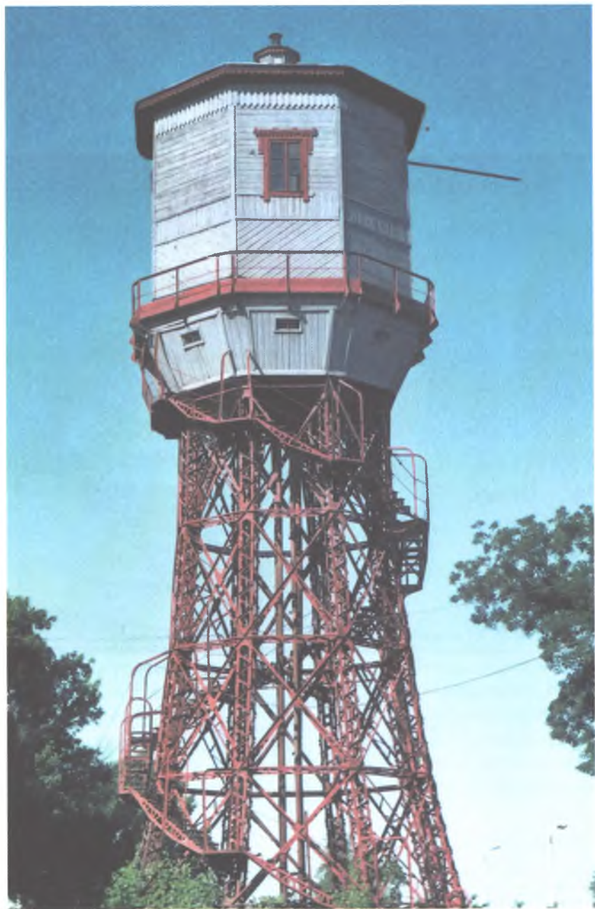
Водонапорная башня на станции Ташкент.
