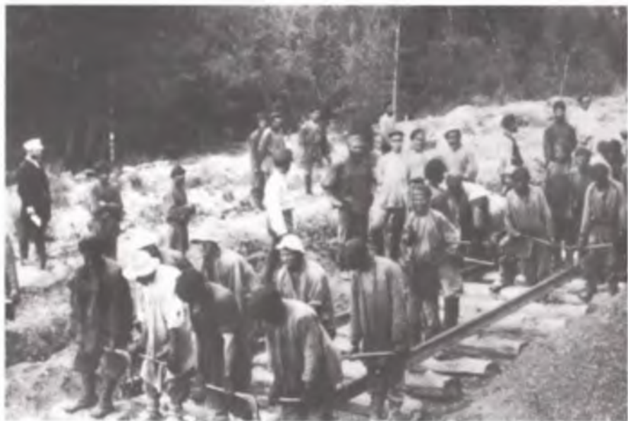
Строители Ташкентской ж. д. 1902 г.
