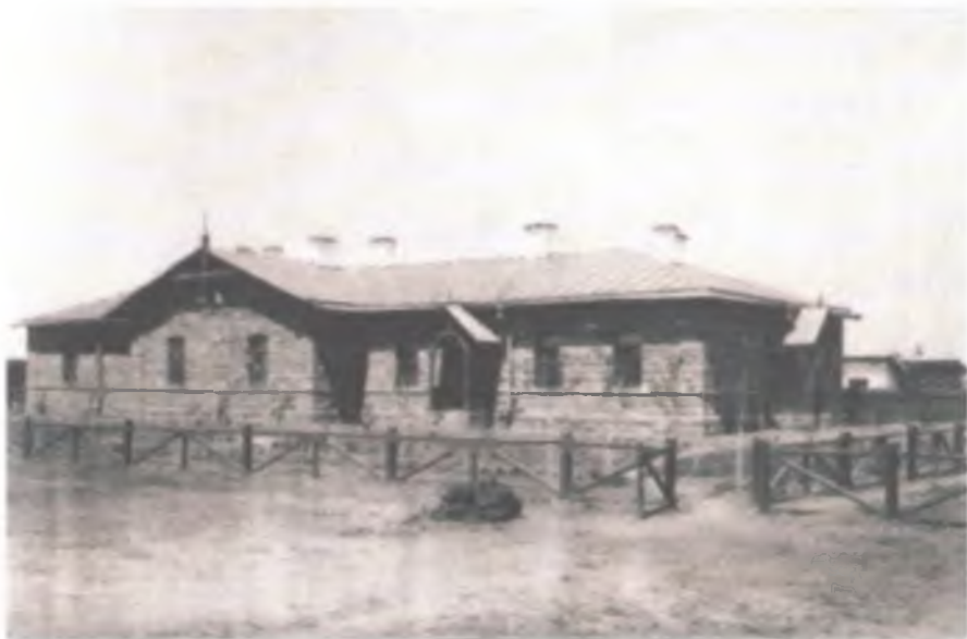
Жилой дом на ст. АКТЮБИНСК. 1905 г.
