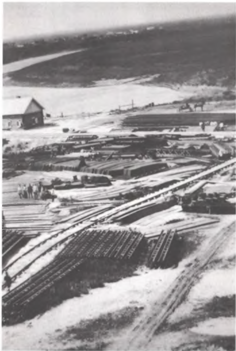
Строительство одного из участков Ташкентской ж.д. 1902 г.
